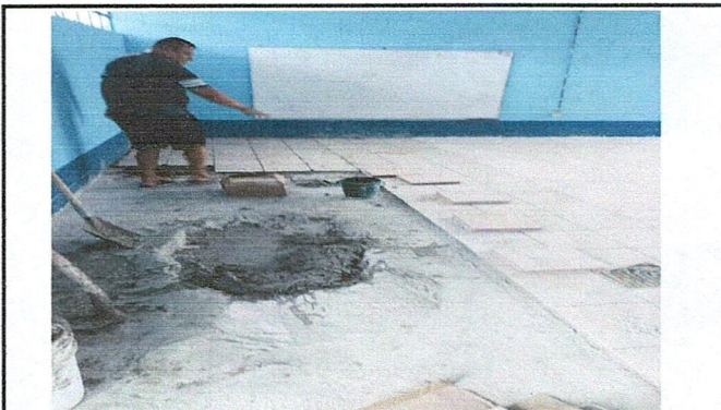
Foto 4: Mejoramiento de piso en aulas del centro educativo.
