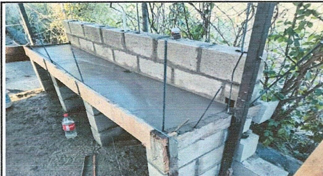
Foto 2: Realización de 3 lavamanos de cemento.
