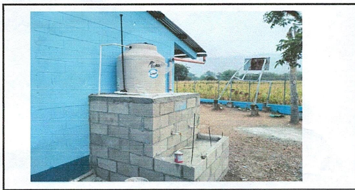
Foto5: Proceso del abastecimiento de agua de block, colocacion de rotoplas, chorros y tuberías
